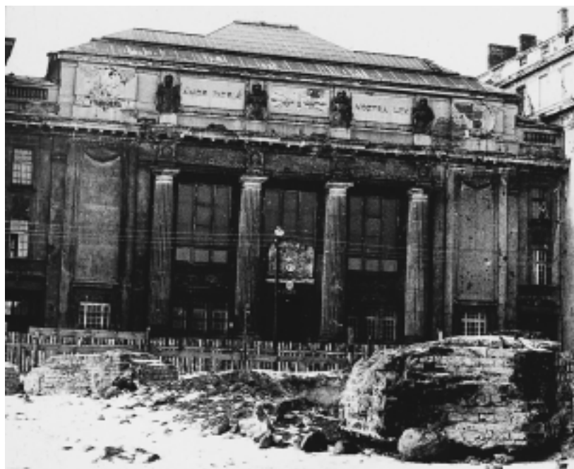
Gmach Biblioteki Ordynacji Krasieńskich przy ul. Okólnik 9 zniszczony w październiku 1944 r.
